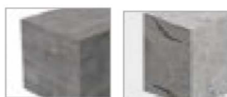
Betão fissurado e
